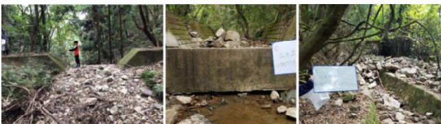
(b) 左：西側谷の砂防ダム満砂状態、中・右：東側谷の大広川に流れ込んだ土石の状態
