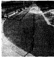
2 廿日市木材港地割れと噴砂
