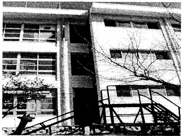
図-6 校舎と校舎間のエキスパンションジョイント
