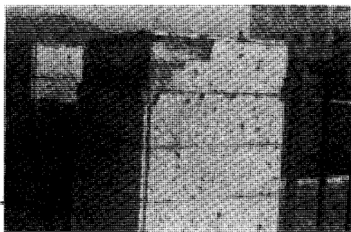
写真2 壁板の剥落
