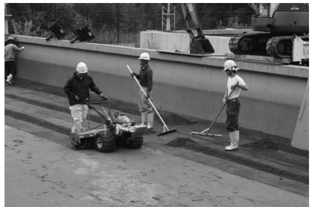
図2 機械化された緩速ろ過池の掻き取り作業 (広島県沼田川水道事務所管内にて、著者撮影)
