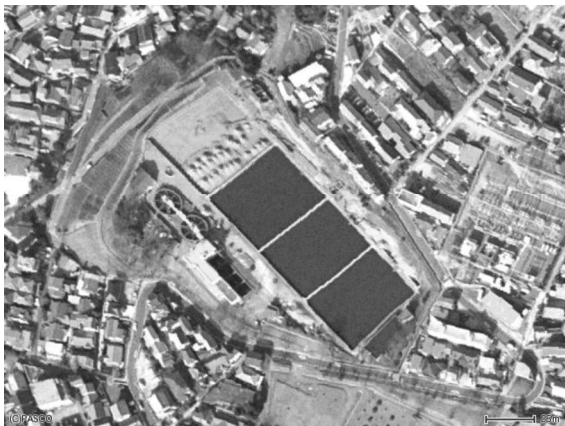
図2 平原浄水場の空中写真
