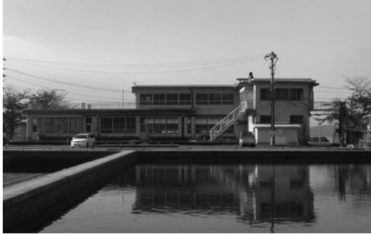
図1 平原浄水場の緩速ろ過池 (手前) と管理棟 (奥)
