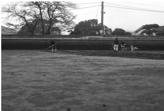
図2 緩速ろ過池の砂層の漉き取り作業の光景
